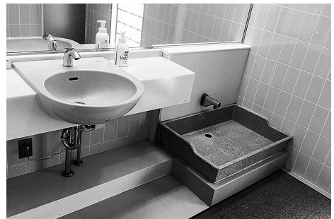
写真1 トイレ内に設けられた足洗い場
